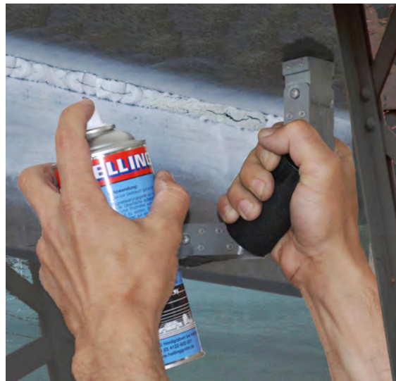
Проверка сварных соединений моста с помощью черной магнитопорошковой суспензии BW 333 и белой фоновой краски NR 104 A
